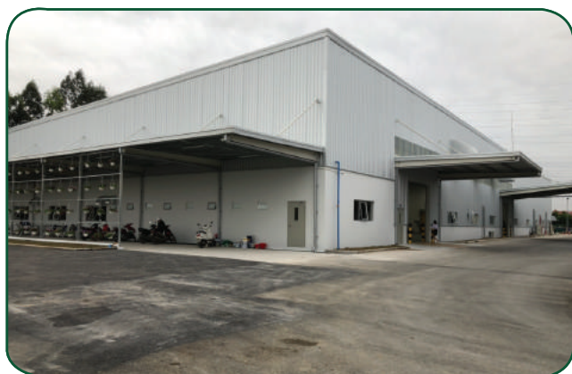
XÂY DỰNG NHÀ XƯỞNG / FACTORY
