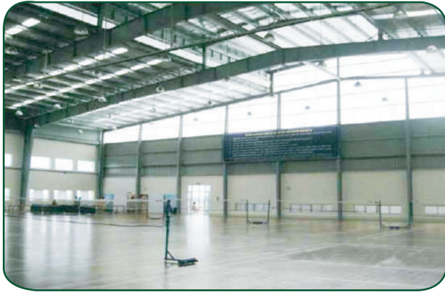
XÂY DỰNG NHÀ THỂ THAO / SPORT CENTER
