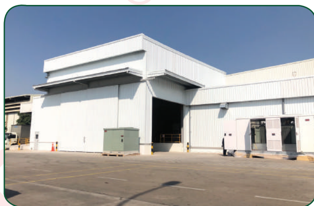
XÂY DỰNG NHÀ KHO / WAREHOUSE
