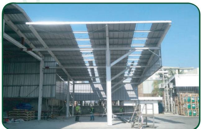
XÂY DỰNG NHÀ CHỨA RÁC / GARBAGE WAREHOUSE
