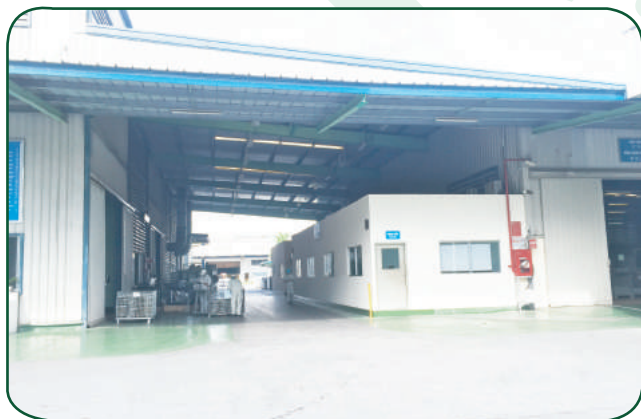
CẢI TẠO MÁI NHÀ XƯỞNG FACTORY'S ROOF IMPROVEMENT
