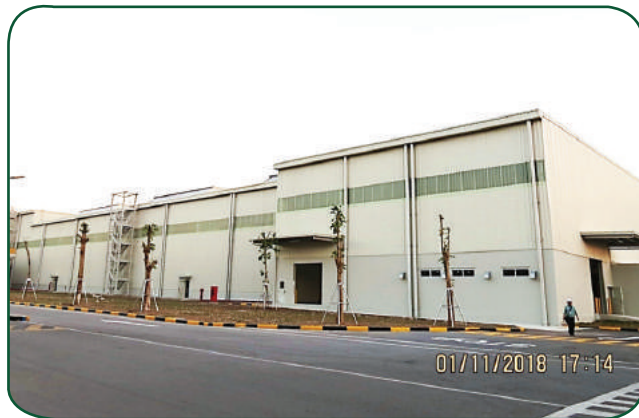
XÂY DỰNG NHÀ XƯỞNG / FACTORY
