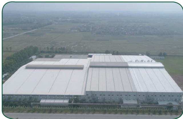
XÂY DỰNG NHÀ XƯỞNG / FACTORY
