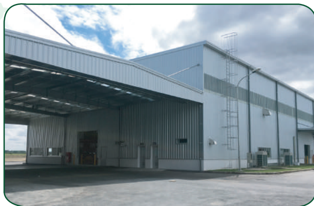
LÀM MÁI CHE NHÀ KHO / WAREHOUSE ROOF
